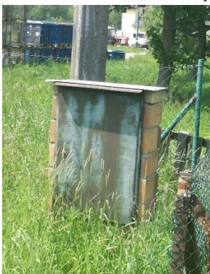
Obrázek č. 2.1.1.7: Rozvaděč veřejného osvětlení (RVO)
